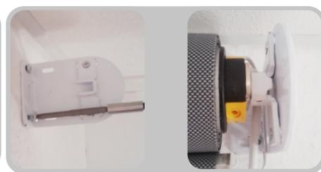
Messen Sie die Gesamtlänge des Rollos (inkl. Lager), zeichnen Sie die Höhe der Lager waagrecht an und markieren Sie die Dübellöcher (bzw. verschrauben Sie direkt z.B. bei Holz).
