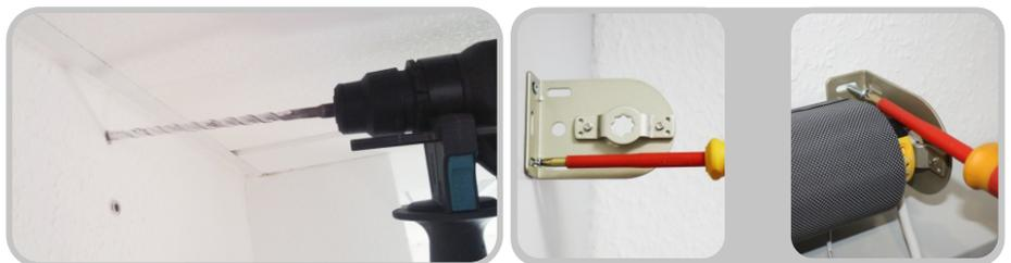
Messen Sie die Gesamtlänge des Rollos (inkl. Lager), zeichnen Sie die Höhe der Lager waagrecht an und markieren Sie die Dübellöcher (bzw. verschrauben Sie direkt z.B. bei Holz).
