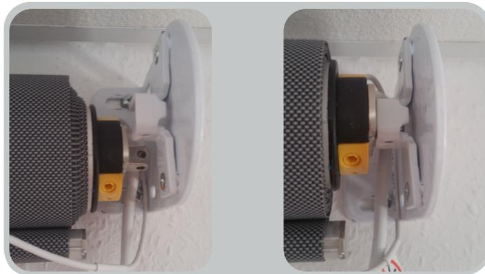
Nun stecken Sie die den Motorkopf in das Antriebslager.
