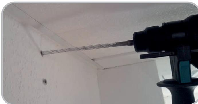
3.) Messen Sie die Gesamtlänge des Rollos (inkl. Lager), zeichnen Sie die Höhe der Lager waagrecht an und markieren Sie die Dübellöcher (bzw. verschrauben Sie direkt z.B. bei Holz).
