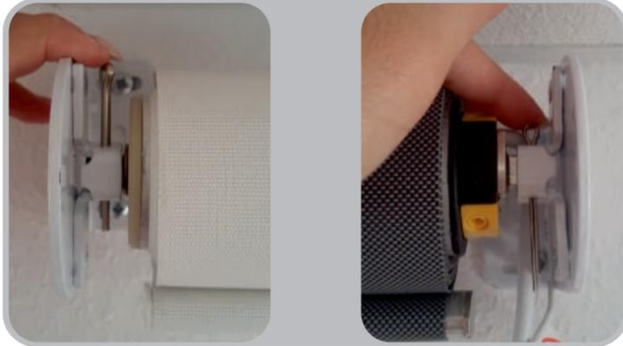
5.) Sichern Sie die Walzenkapsel und das Lager sowie den Rohrmotor mit den mitgelieferten Splints.
