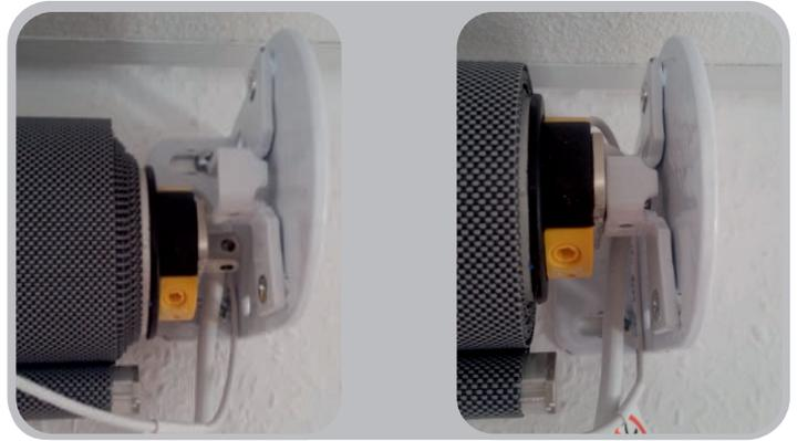
Nun stecken Sie die den Motorkopf in das Antriebslager.
